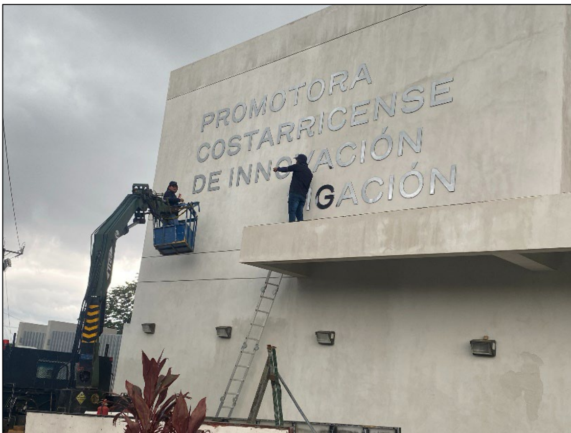
Imagen 7 Rotulación del edificio de la PCII, 2024
